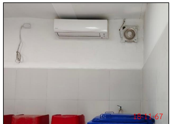
การปรับปรุงภูมิติดตั้งเครื่องปรับอากาศ ในห้องพักมูลฝอยติดเชื้อ
